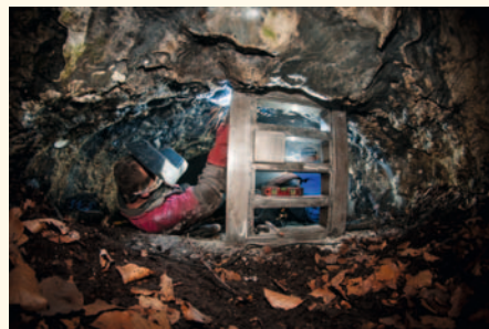
Montaż kraty w Jaskini Zbójcekiej. Prowadzenie prac w takich warunkach nie jest łatwe.
