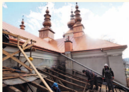
Cerkiew w Krynicy Zdroju podczas remontu dachu. Prowadzenie prac zimą było wielkim wyzwaniem dla ekipy budowlanej.
